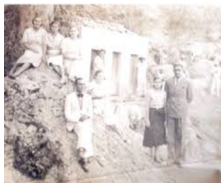
Banheiros públicos do Olho d'Água da Bica - década de 1940 Acervo MHC.
