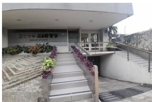
Vista Ingreso a Edificio
