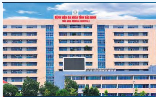
Bệnh viện Đa khoa tỉnh Bắc Ninh
