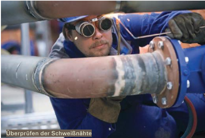
Überprüfen der Schweißnähte
